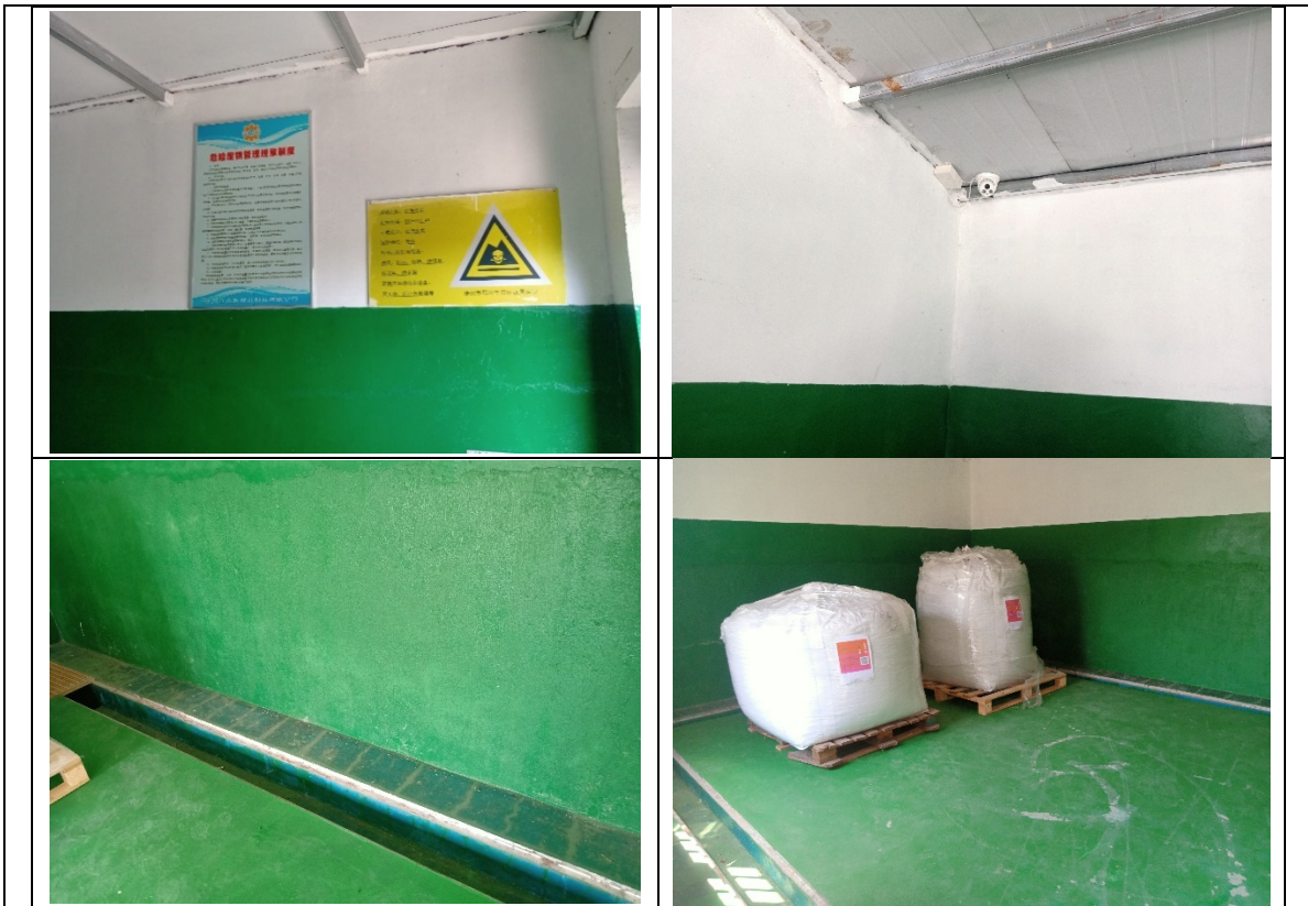
图 3-2 危废库现状建设情况
