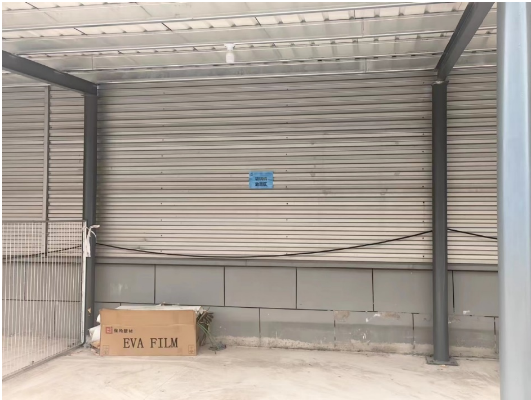
图 3-1 一般固废库现状建设情况
